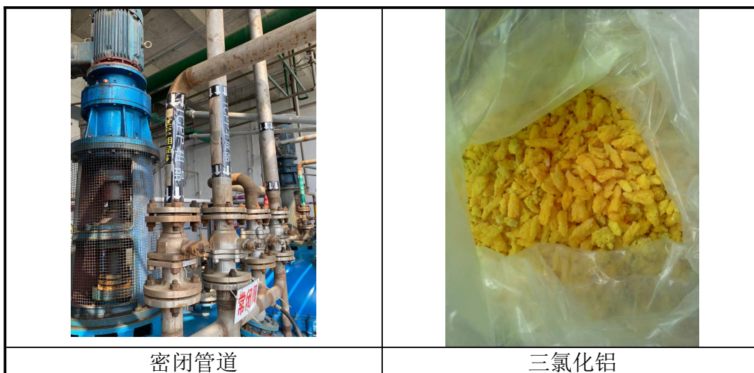
图 2.4-12-1 厂区无组织控制措施图
