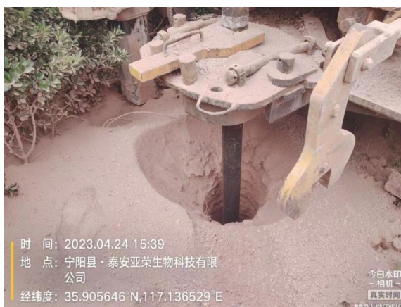
图4.2-1 监测井钻进施工
