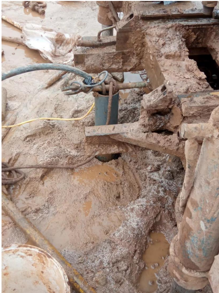
图4.2-1 监测井钻进施工
